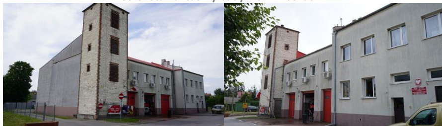
Fot. 3. Stan aktualny budynku w Piaskach
